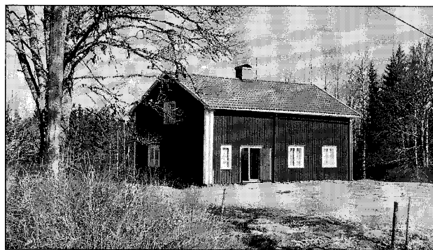
”Äldre manbyggnaden Där Nere i Abborrsjön från 1875, i renoverat skick. Huset Per Jonsson byggde.”
